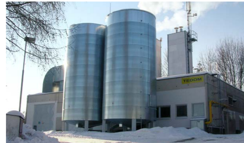
Fernwärme, Světlá n. Sázavou, Česká republika
