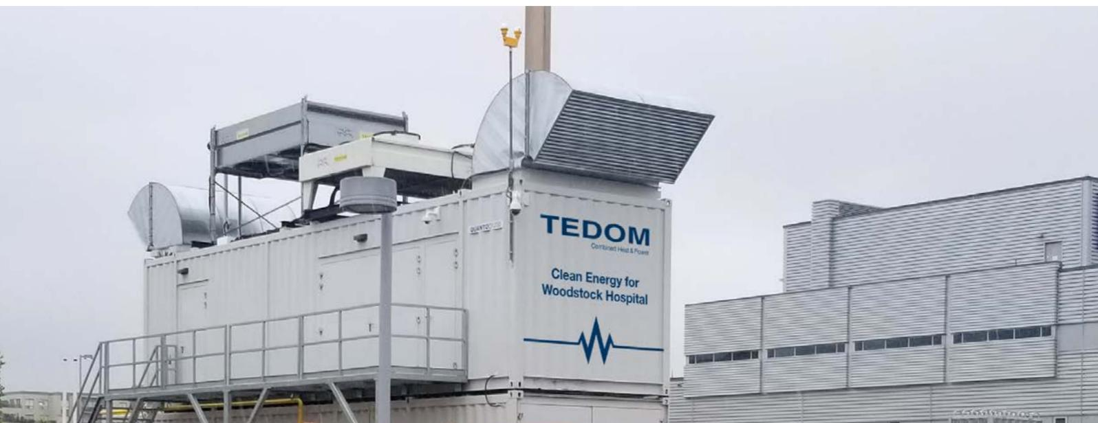
Krankenhäuser sind zweifelsohne ein guter Ort für die Installation von KWK-Technologien. Diese Anlagen verbrauchen viel Strom und haben durch ihren Dauerbetrieb auch viele Möglichkeiten für die Abwärmenutzung. Das Blockheizkraftwerk ist eine zuverlässige und hocheffiziente Quelle der elektrischen und thermischen Energie, die im Dauerbetrieb sein oder flexibel auf unerwartete Situationen reagieren kann.
